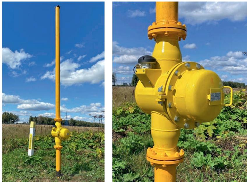
Рис. 8. КП ТМ контроля загазованности перехода, установленный на вытяжной свече
