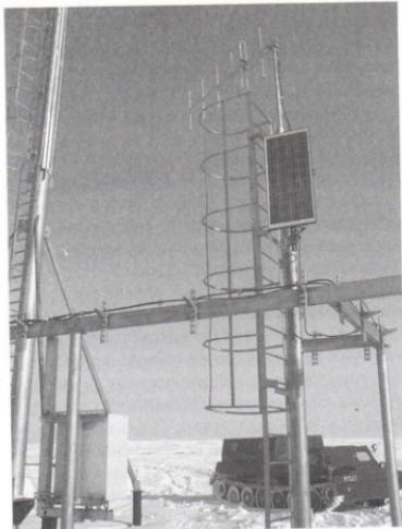
Рис. 2. Контролируемый пункт куста газовых скважин
