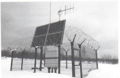
Рис. 6. Контролируемый пункт телемеханики с возобновляемым источником электроэнергии на базе солнечной батареи
