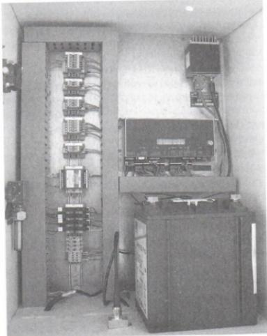
Рис. 3. Шкаф контролируемого пункта
