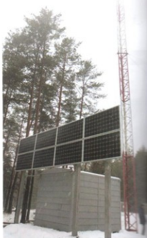
Рис. 1. КП телемеханики Брянского ЛПУ с ВИЭ
