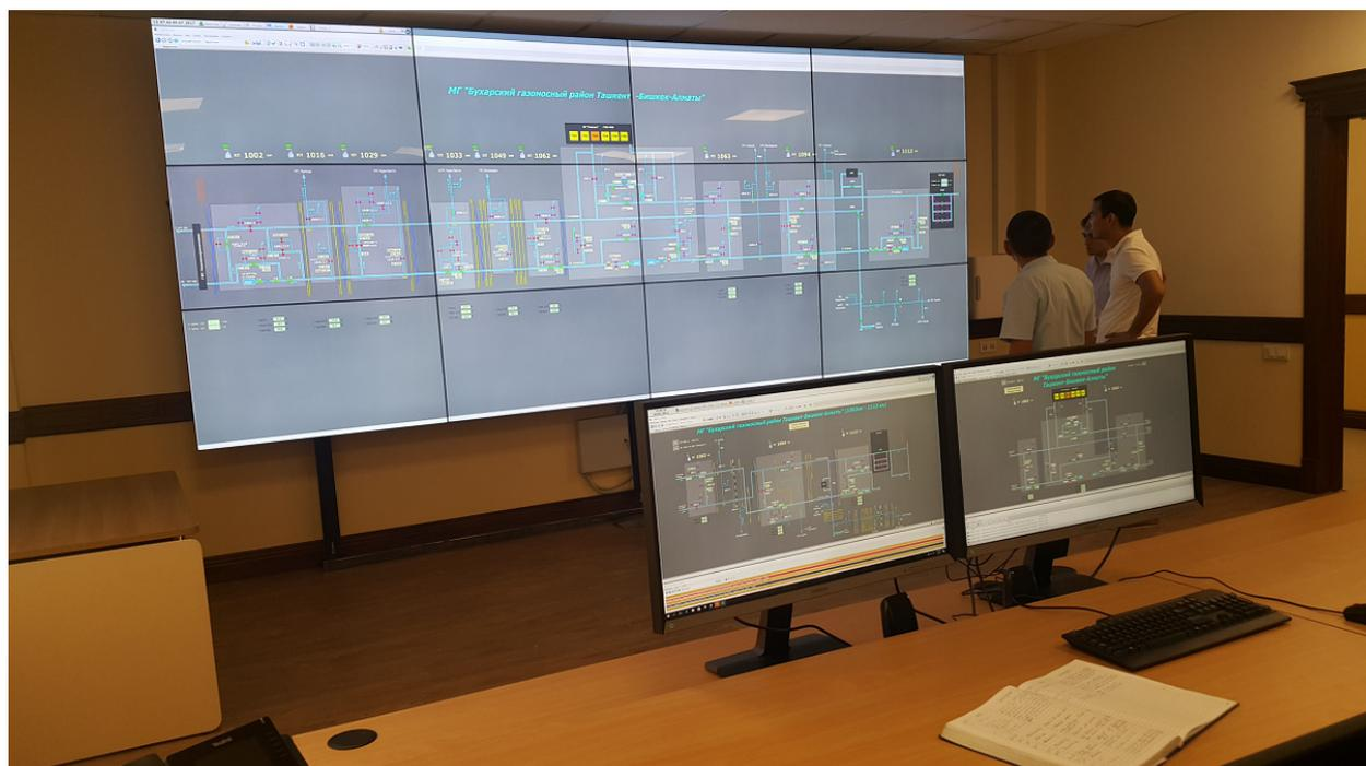
Рис. 2. Видеостена и АРМ диспетчера, отображающие видеокadres СОДУ СПУРТ-Р
