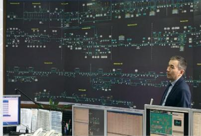
Масштабный проект по автоматизации газотранспортного предприятия, включает СОДУ на базе СПУРТ, телемеханику линейной части, СКЗ, автоматизацию ГРС и УРГ. На уровне ЦДП применена нестационарная модель газопровода «Волна», интегрированная в реальном времени с системой СПУРТ.
