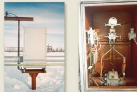
Использование MVT 3808 для измерения дебита скважин является одним из предлагаемых вариантов. Альтернативным вариантом является применение приборов других производителей. В этом случае подключение датчиков (вычислителей) осуществляется по аналоговым каналам 4-20 мА или цифровым каналам RS-485 и протоколу HART, MODBUS, либо по заказному протоколу.
