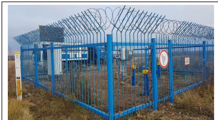
Вариант размещения «малого КП» (БУКа) с ВИЭ на территории крановой площадки.
