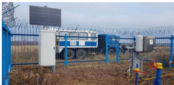
КП ТМ с ВИЭ для однопоточного газопровода с размещением в периметре крановой площадки
