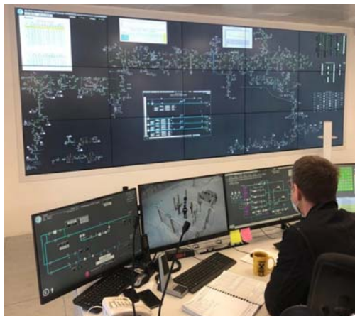
ПУ телемеханики, оборудованное видеостеной и системой видеонаблюдения
